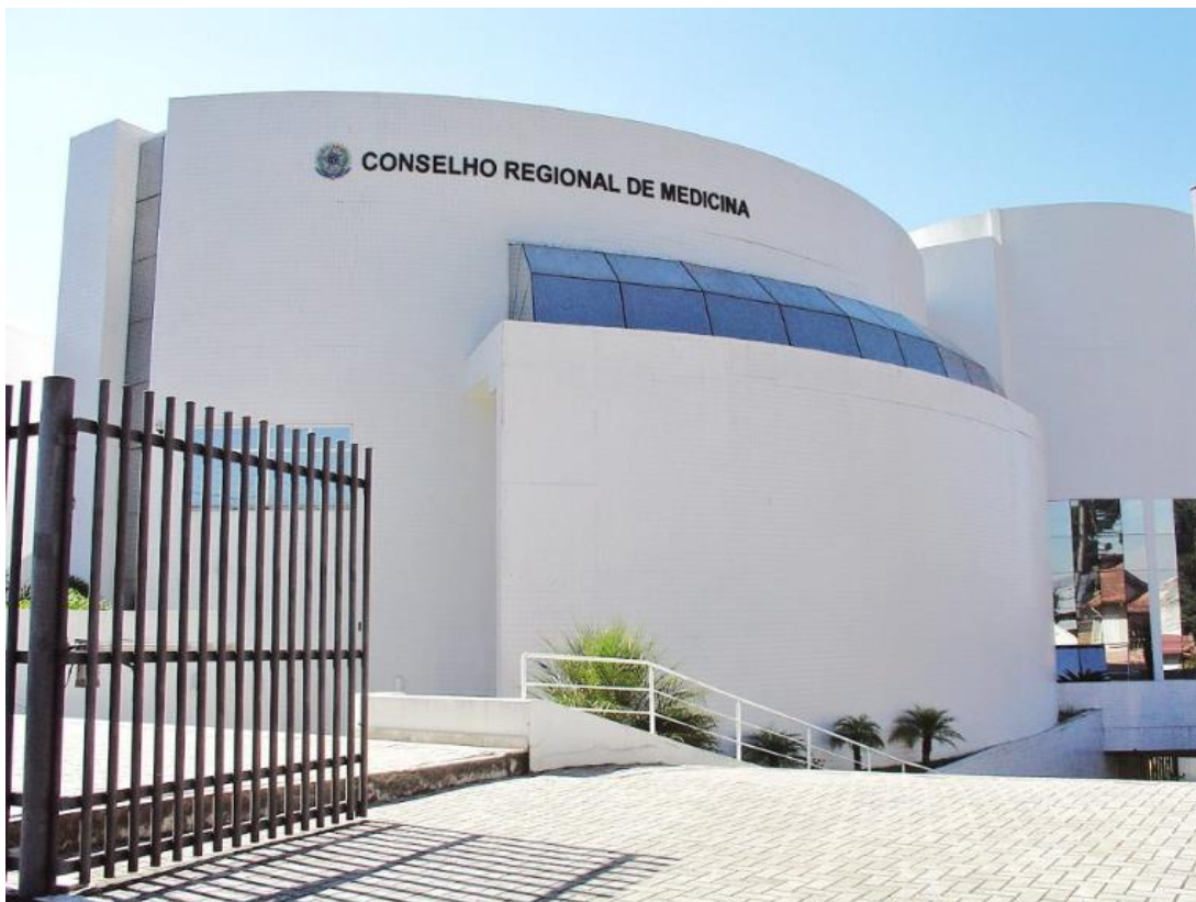
Foto 01 – Vista frontal da Edificação
